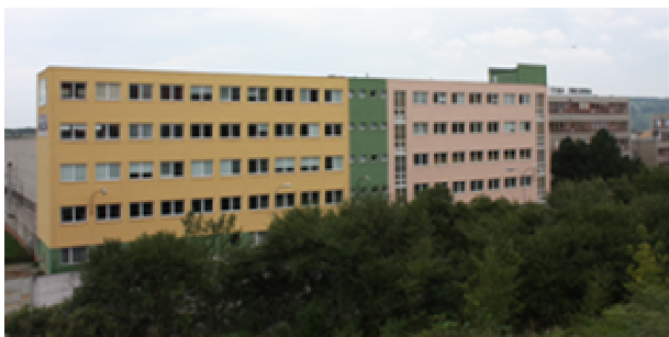
Budova teoretického vyučování SŠ – COPT Uherský Brod na ulici Svatopluka Čecha
